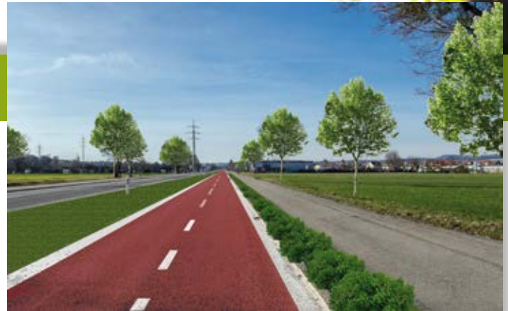
Neue Verkehrsfläche als Radweg Süßen - Salach (nachher).
