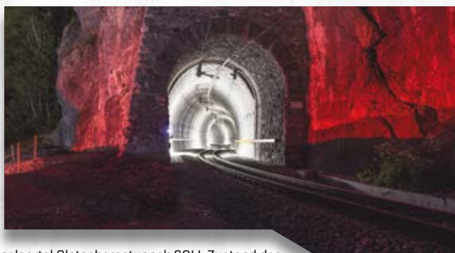
Tunnelportal Gletscherastunnel: SOLL Zustand der Normalbauweise mit Schotterbett anstatt Fester Fahrbahn und Betontübbingen (Außenschale des Tunnels).
