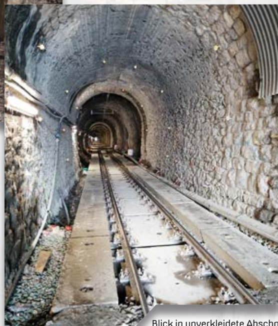
Blick in unverkleidete Abschnitte des Tunnels mit eingebauter Fester Fahrbahn.
